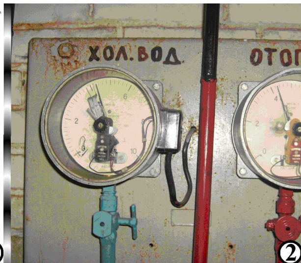
Рис. 4. Напор (давление) во внешней системе холодного водоснабжения: 1) выходное давление на Фрунзенской ПНС; 2) показание манометра на вводе (при отключенной системе горячего водоснабжения дома)
